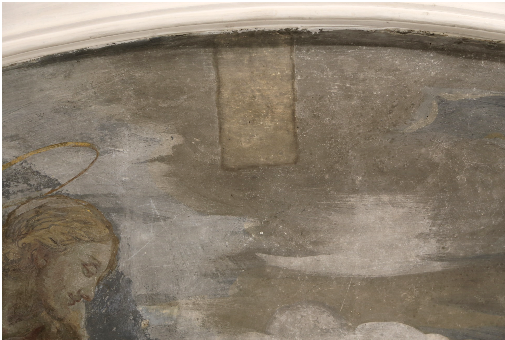
Partie nieba, próba oczyszczania malowidła z brudu, wykonana metodami chemicznymi. Widoczne przemalowania chmur białą, kryjącą farbą.
